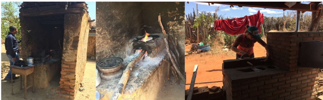
Figura 01 – Fogão a lenha tradicional (a) e fogão agroecológico, sendo construído por uma pedreira (b)
